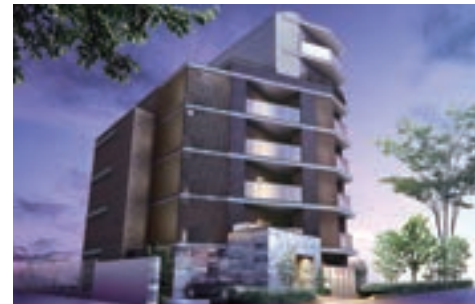
飯田橋コンパクトマンションプロジェクト
